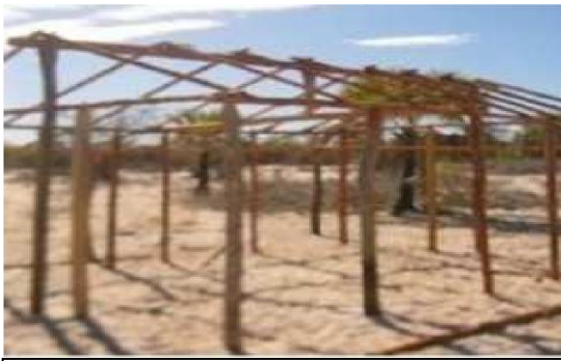
Charpente d'une case traditionnelle, construite avec des palétuviers Avicennia
