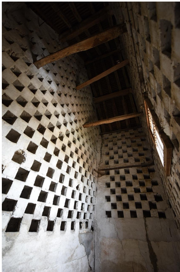
Figure 8. Ferme du château, pigeonnier accolé à la façade, de la grange ; vue intérieure sur les boulins (photo Emmanuelle Jacquot CD93).
