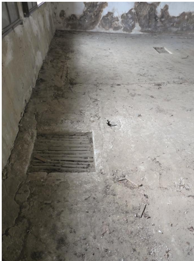
Figure 24. Fenil au-dessus de l'étable à bœufs de la ferme du château avec aérations au sol (photo Ivan Lafarge, CD93).
