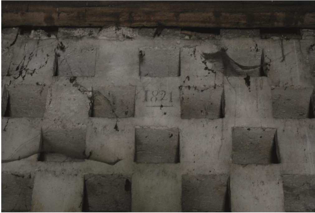
Figure 4. Pigeonnier (fuite) de la ferme Zaffani, vue générale des boulins et date peinte (photo Ivan Lafarge, CD93).
