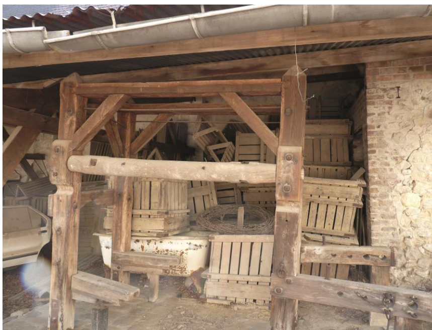
Figure 20. Ferme du château, travail à ferrer (photo Ivan Lafarge, CD93).
