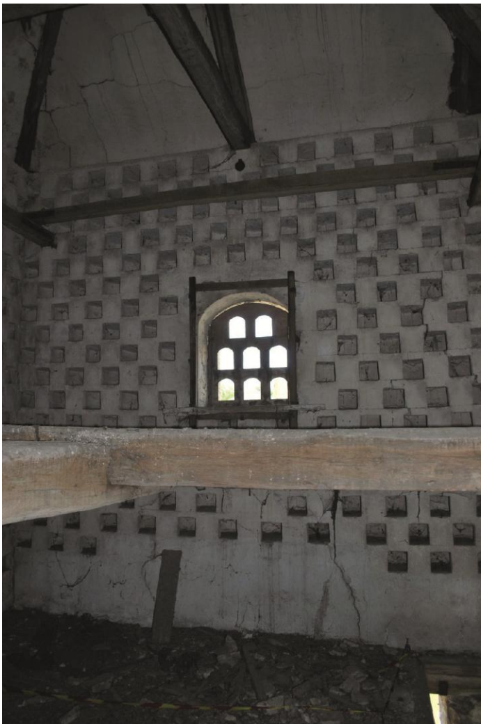
Figure 6. Pigeonnier (fuite) de la ferme Zaffani, tirants et perchoirs (photo Ivan Lafarge, CD93).
