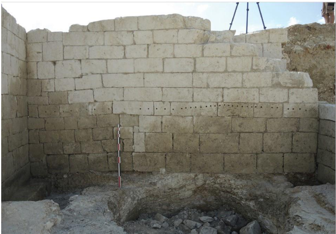
Figure 10. Vue du mur ouest du bâtiment trapézoïdal, côté sud. Détails des trous dans le parement. Cliché C. Chauveau, 2018.
