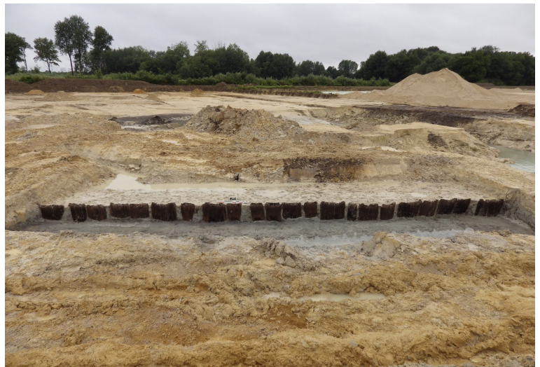
Figure 6. Vue générale d'une large section des bois de la palissade 2146. © Éveha.
