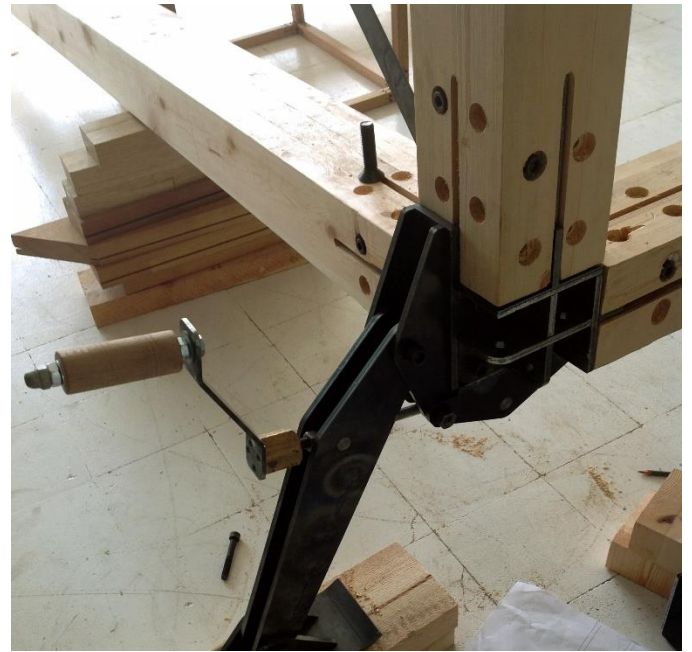
Figure 21. Système constructif à assemblage à sec
